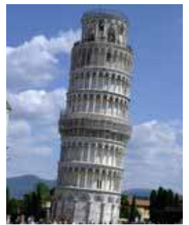
図2 不同沈下
