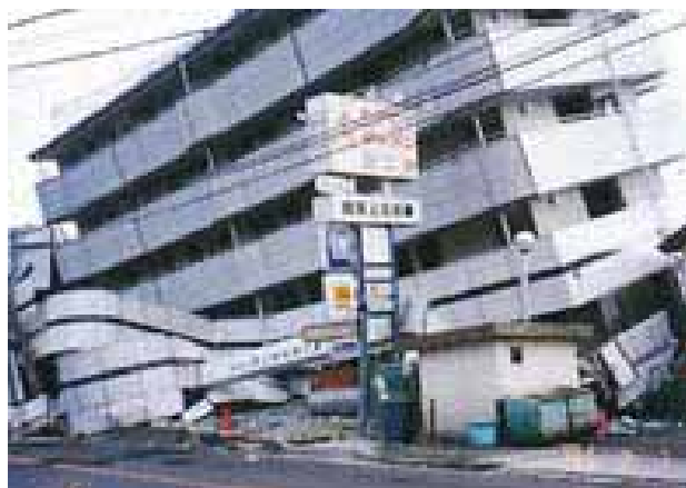
図-4 構造物沈下の様子 1
