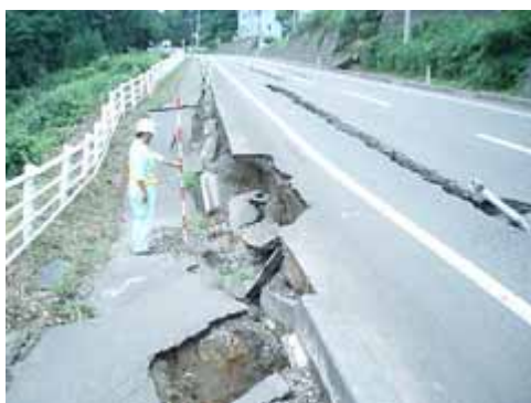
図－9 側方流動によりできた道路の大きな陥没と段差
