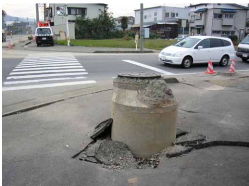
図－6 浮き上がりによる被害の様子 1
