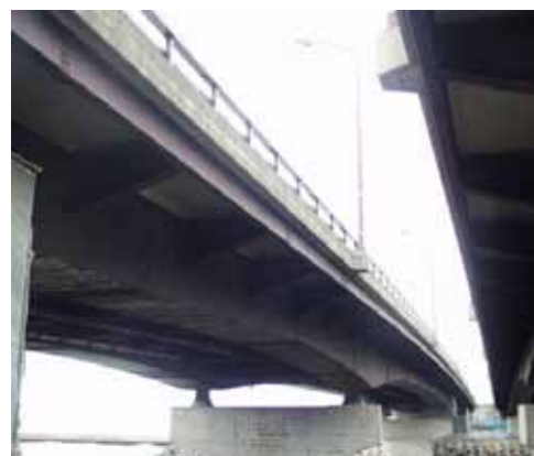
写真-3 耐候性鋼を使った橋
