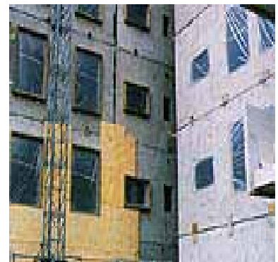
(外断熱外壁工事の例)
