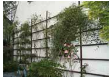
登はん補助材を使用した壁面緑化
