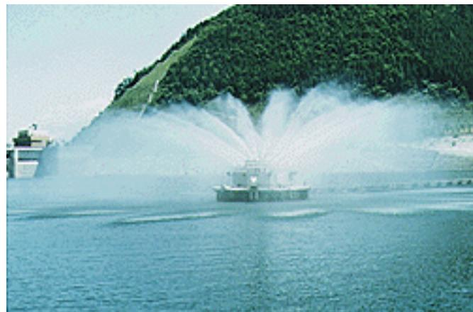
この写真は実際に曝気処理をしているところである。吹き上げた水の落下によって強制的に酸素を水中に溶け込ませることができる。
