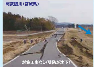
対策工事なし(堤防が沈下)
