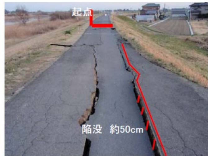
↑ 天端舗装陥没状況(約50cm)
