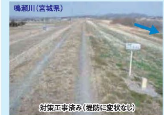
対策工事済み(堤防に変状なし)
