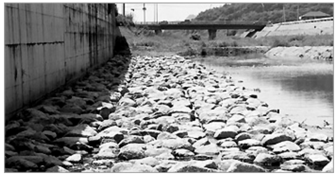
(b) 床固め工（河床・岸部の洗掘防止）
