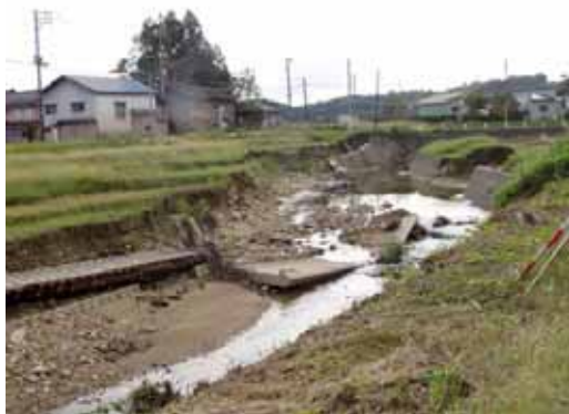
(c) 蛇行部の洗掘による護岸破壊・河岸浸食の例
