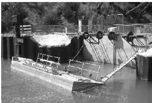
図-4 W地区取水口の魚避けスクリーン Fig. 4 Fish protection screen at the intake gate.
