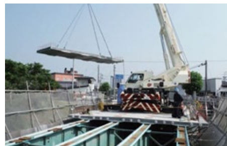
写真-1 PC 床版取替工事
