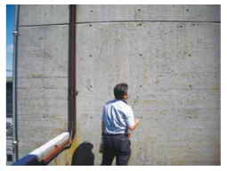
築50年経過後のRC建物調査
