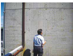
築50年経過後のRC建物調査
