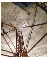
コンクリート仏像内部調査
