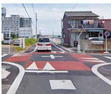
交差点ハンプの設置
