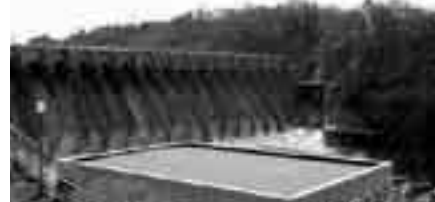
2の水門の並ぶ大井ダム
