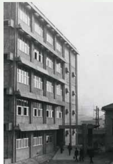
▲本館第1期工事完成
