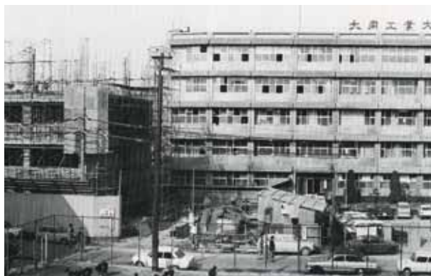
▲2号館建設の様子
