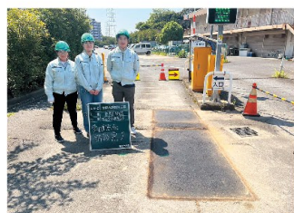
▲舗装完了の様子
