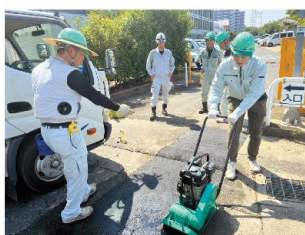
▲施工している様子
