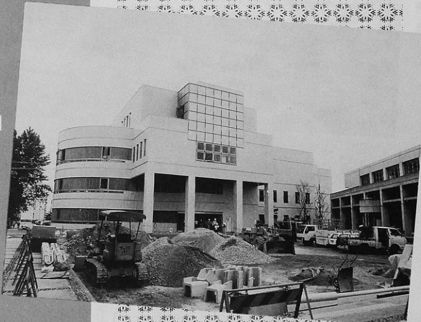
平成元年6月完成をめざし、姿を見せ始めた新図書館
