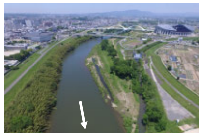
図 1-3 白浜工区全景
