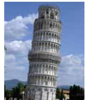
図2 不同沈下の例<sup>4)</sup>
