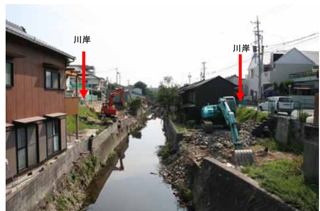
写真-1 中橋下流の河道内住宅(2008.10.08撮影)
