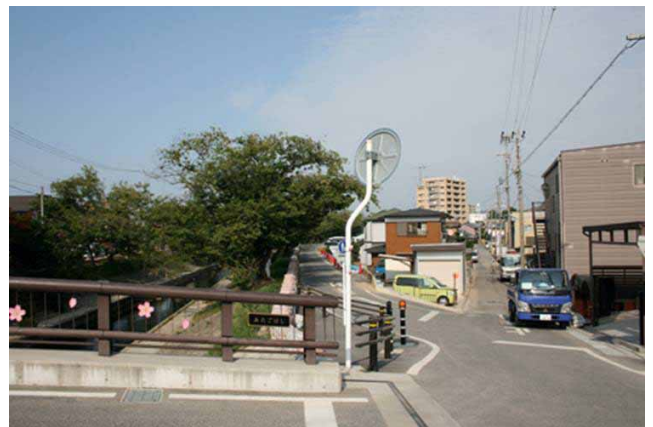
写真-3 越流部 (愛宕橋左岸, 上流を望む)
