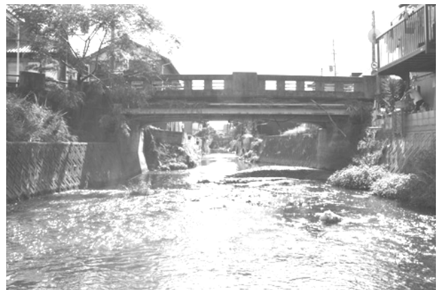
写真-2 中橋上流から見た河道狭窄部 (2008.10.08撮影)
