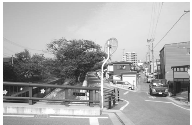
写真-3 越流部（愛宕橋左岸，上流を望む）
