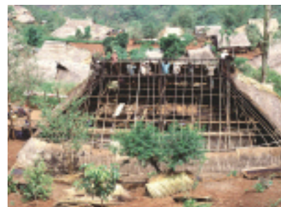
屋根の葺き替え風景。巨大な屋根なので、「結い」で作業する。
