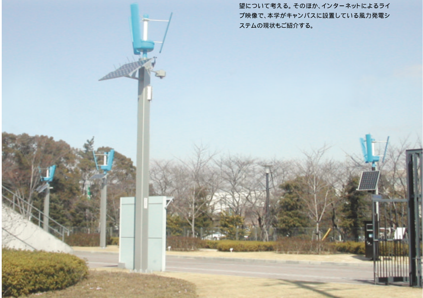
大同工大正門に4基設置された都市型風力発電装置
